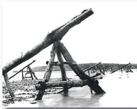
„Hottelbalk“ – низ импровизованих прејурека за десантне чамце, искошених греда са проширеним крајевима. У време пиле конструиције налазе се под водом.
